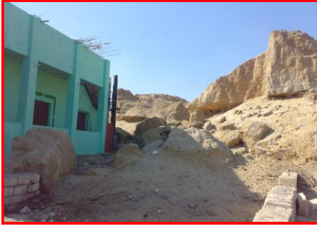
صورة (١١) : أخطار السقوط الصخري على الوحدات السكنية المبنية فى حضيض المنحدرات بمنطقة سدمنت الجبل، كما يلاحظ وصول الكتل المتساقطة حتى مدخل المنزل. وتمثل منطقة خطر سقوط صخري شديد جداً. ناظراً اتجاه الجنوب الغربي
