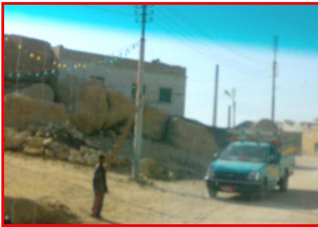
صورة (١٢) : أخطار السقوط الصخري على الوحدات السكنية والطريق الرئيسى بمنطقة سدمنت الجبل، كما يلاحظ وصول الكتل المتساقطة حتى الطريق. وتمثل منطقة خطر سقوط صخري وشيك. ناظراً اتجاه الجنوب الغربي
