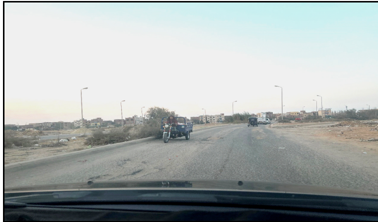
شكل (١٢) : الشارع المتجهة الي منطقة ابني بيتك وتظهر رداءه الرصف وعدم الاهتمام بالشوارع الداخلية للمدينة.
