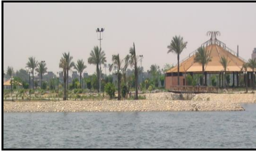
صورة (١٠) : التكسيات الحجرية المقامة أمام مستشفى القوات المسلحة مما يسهم في تزايد التيارات المائية المرتدة الى الجزيرة ومن ثم تآكل أطرافها المواجهة لها.
